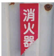
× 標識の破損
