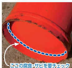
× 底部の腐食
