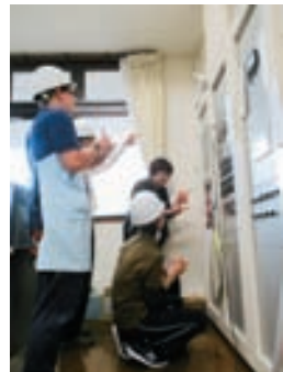
防災監視盤の確認
