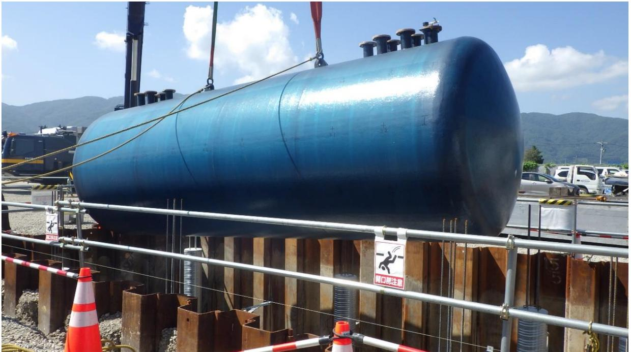
地下貯蔵タンク中間検査（タンク据え付け）の様子
